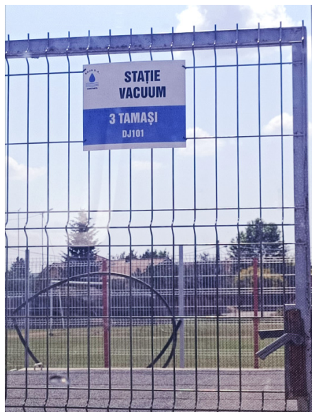
■ Stație vacuum pe conductele de apă uzată din Corbeanca (sursa: imagine surprinsă pe parcursul vizitei pe teren, realizată de evaluatori)
