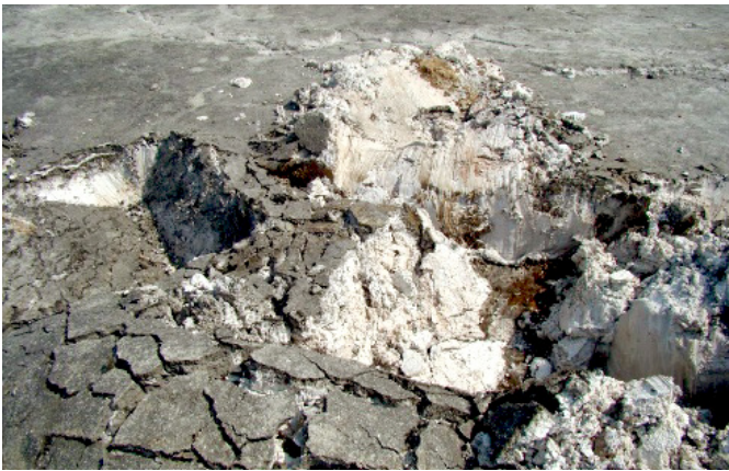
■ Înainte de intervenția POIM (Târgu Mureș)
