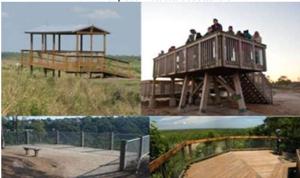
Poza 7. Exemple de infrastructură de observare
